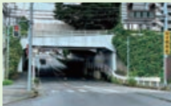
第4浜街道ガード（国道356号）
