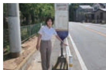
◎県単交通安全対策として我孫子中学校前の国道356号沿いに防止柵設置。
